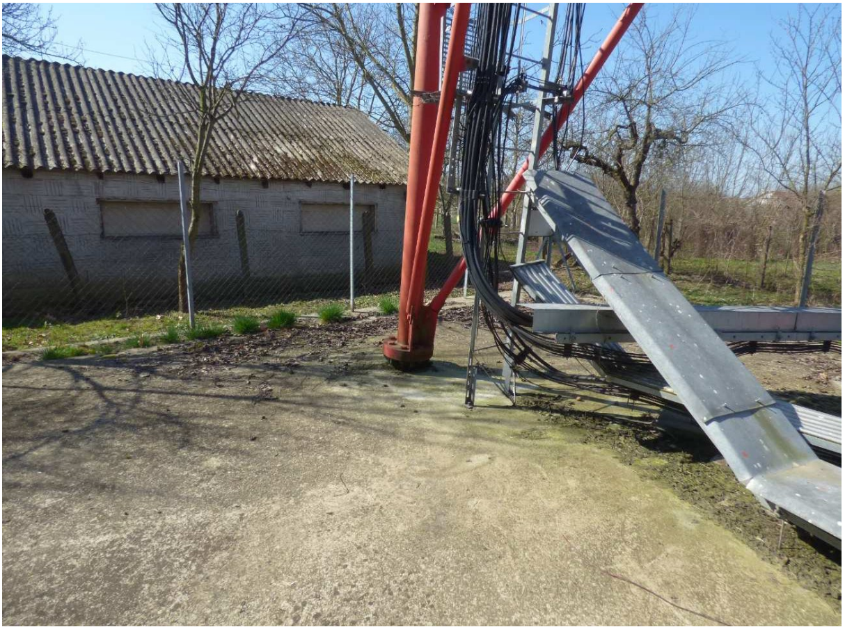
A torony alapozása és a szomszédos 39 hrsz. ingatlanon meglévő gazdasági épület
