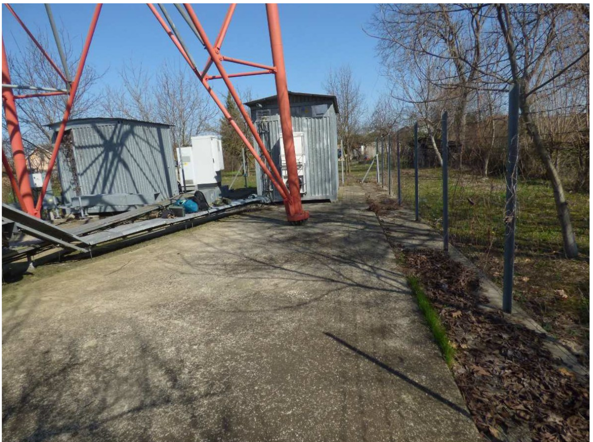
A torony alapozása és technológiai létesítményeinek építményei a kertvég felől
